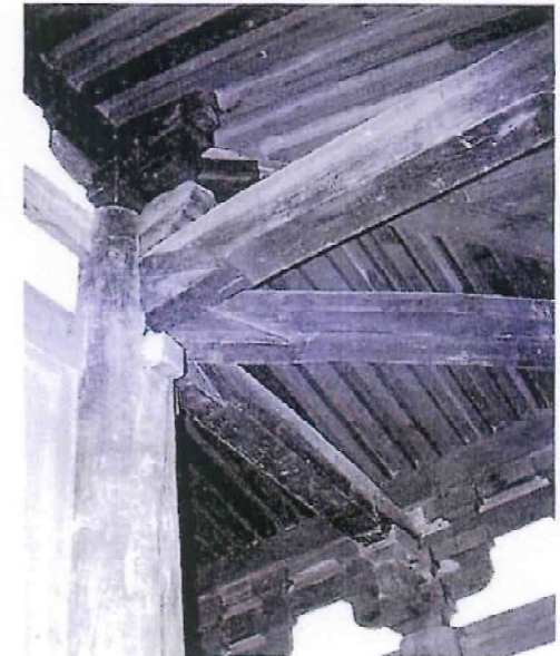
内陣裏、小屋組の状態
