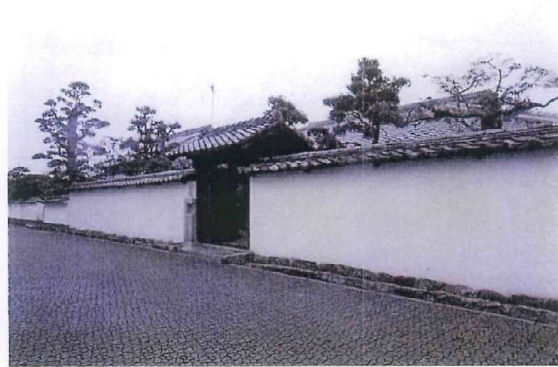
南側前面道路より外観
